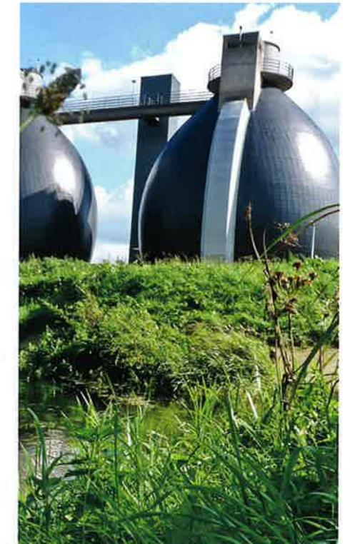
In de vergister op de rwzi Hengelo wordt van rioolslib biogas gemaakt, waarmee energie wordt opgewekt. De installatie wordt omgebouwd tot een Energiefabriek, die meer energie produceert dan nodig is op de rwzi. Het restant aan (waterschaps)energie wordt dan teruggeleverd aan het elektriciteitsnet.
